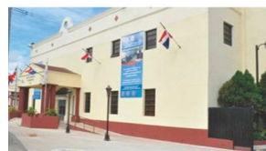
Figura 5.2.4 Edificio IDAC 30 de marzo, con rampa
